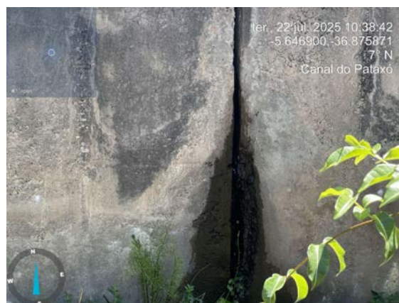
Figura 26 - Deterioração das juntas de dilatação com consequente fuga de água.
