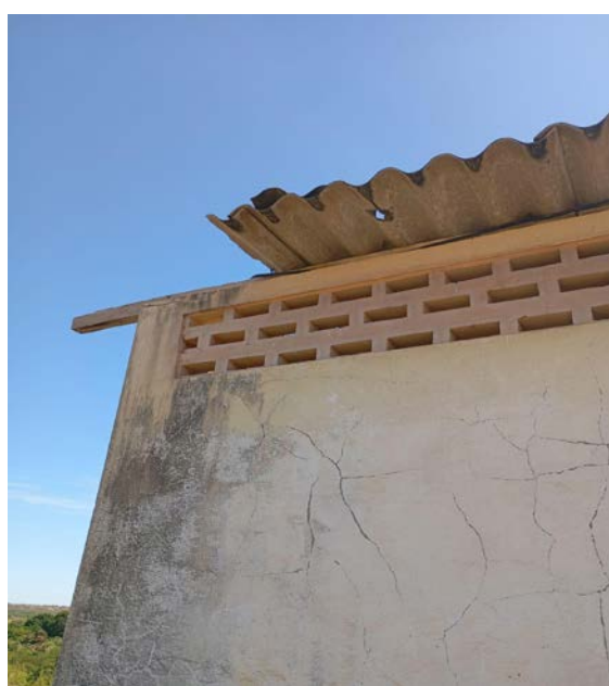
Figura 20 - Deterioração da casa de comandos.
