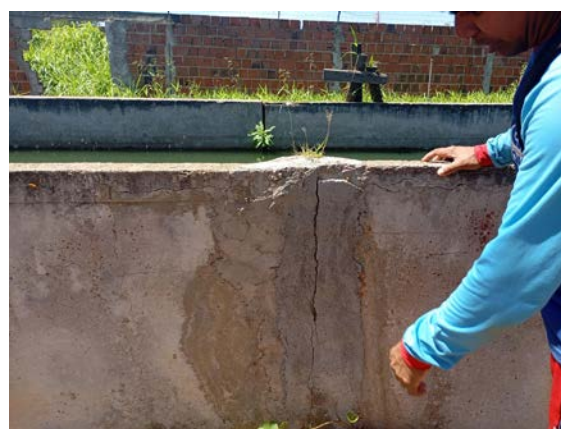
Figura 28 - Deterioração das juntas de dilatação com consequente fuga de água.
