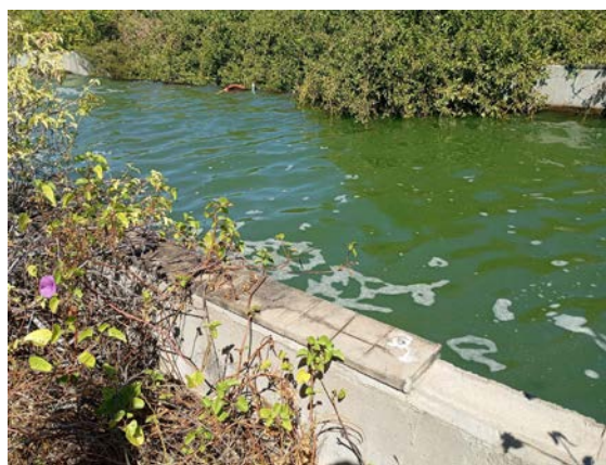
Figura 36 - Deterioração de chapim no início da captação do canal.
