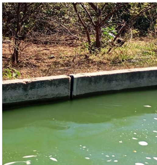
Figura 33 - Deterioração das juntas de dilatação com consequente fuga de água.
