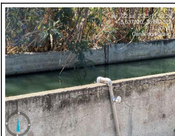
Figura 51 - Captação irregular de água. Fonte: SEMARH-RN (2025)
