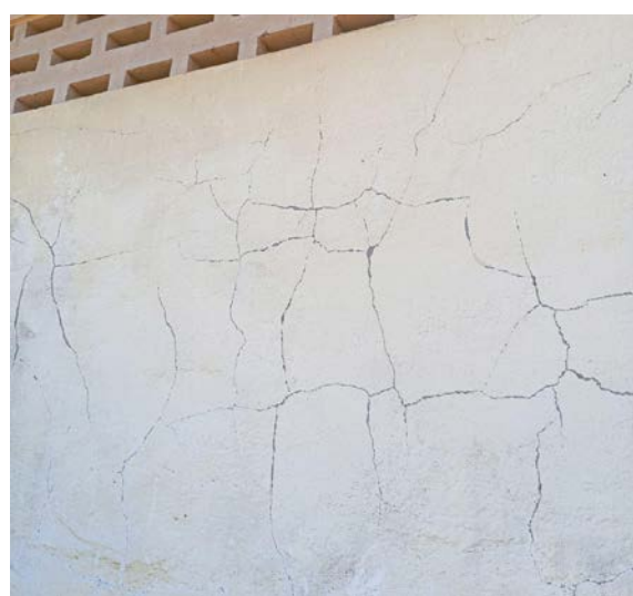
Figura 17 - Deterioração da casa de comandos. Fonte: SEMARH-RN (2025)
