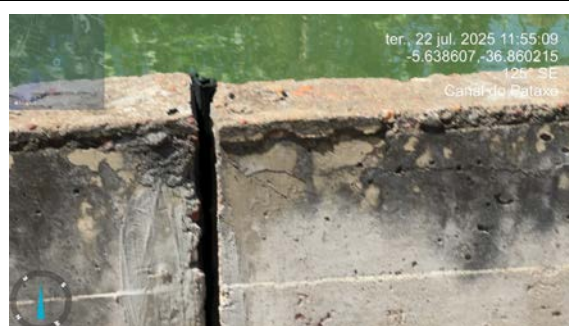
Figura 25 - Deterioração das juntas de dilatação com consequente fuga de água.
